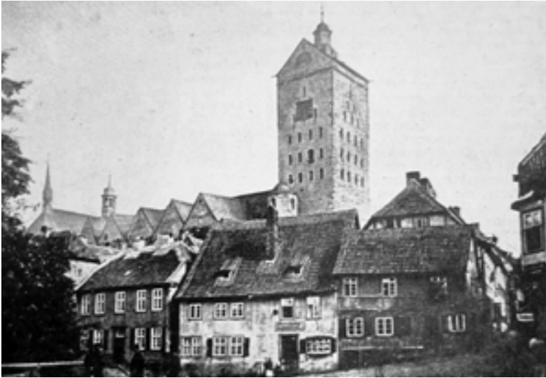
Turmschluss seit 1815 im Januar (11/1) der Blitz eingeschlagen. Rundtürme trugen niedriges Dach. So bis zur Renovierung 1889 [Aus der Mappe: Paderborn 1]
